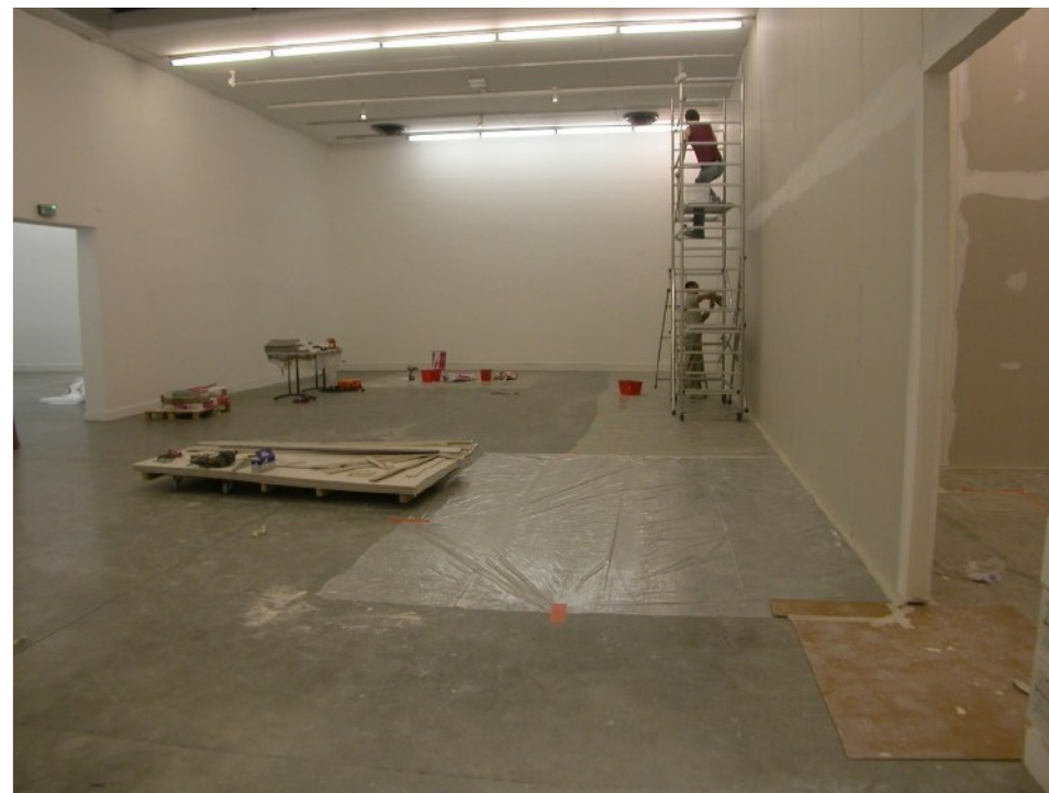
Construction d'un mur dans les galeries, mai 2007 Construction of a wall inside the galleries, May 2007
